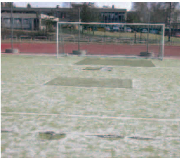
Utslitt dekke med åpne skjøter og felt
