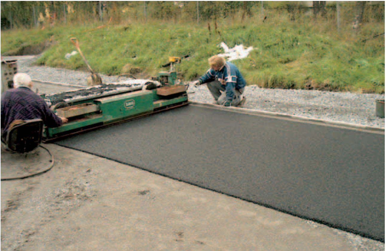
Utlegging av støtdempende sjikt (pad)
