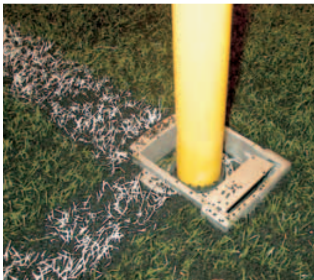
Hjørneflagg i fast fundament
